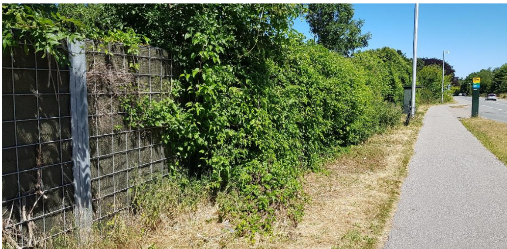
Figur 12: Når tilplantningen lykkes kan en støjskærm ende med blot at ligne en hæk (eksempel fra Hørsholm Kongevej)
