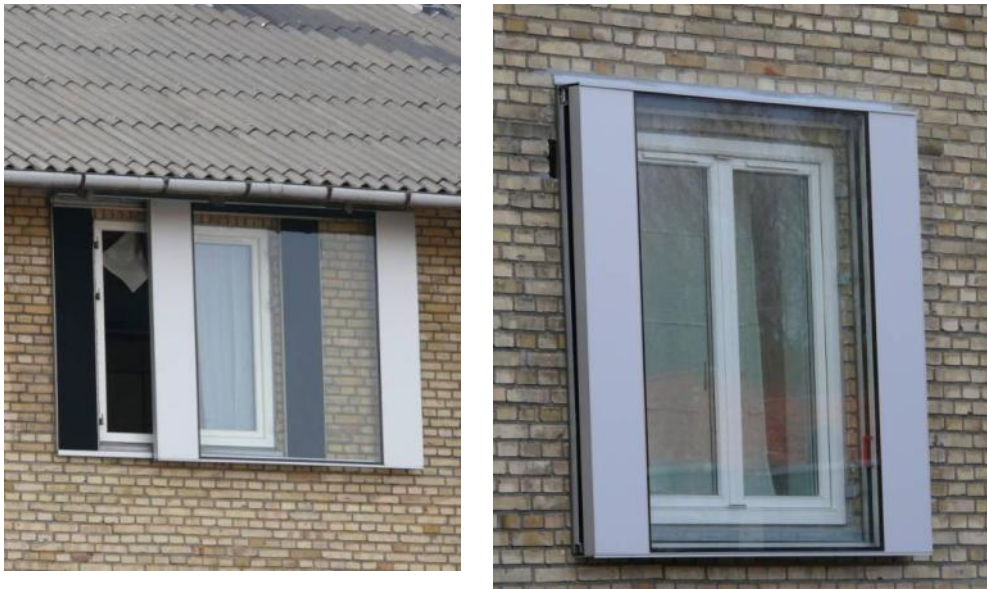
Figur 14. I Folehaven i København har en nogle lejligheder fået monteret en såkaldt lydskodde, der gennem spalter i siderne tillader frisk luft at passere, mens støjen dæmpes. Vinduet kan åbnes på klem bag skodden og skodden kan skyde til side, så vinduet kan åbnes helt.
