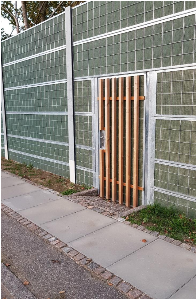
Figur 11: For mindre (private) fodgængerpassager i en støjskærm kan der isættes låger (eksempel fra Kongevejen i Virum)
