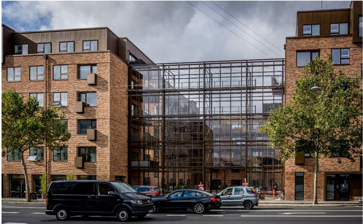
Figur 32. I denne nye bebyggelse, har man anvendt en støjskærm i åbningen mellem bygningerne for at opnå et lavt støjniveau i bebyggelsens gårdmiljø. I facaden mod vejen er der anvendt særligt støjdæpende vinduesløsninger (Gl. Køge Landevej, København).
