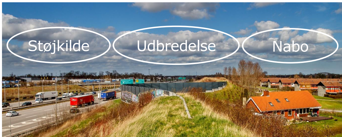
Figur 24. Dæmpning af trafikstøj kan ske ved brug af redskaber, der er rettet mod støjkilden, støjens udbredelse og modtageren, det vil sige vejens nabo.
