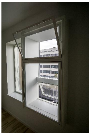
Figur 33. Støjdæmpende multifunktionsvindue (billederne til venstre og i midten). Støjen dæmpes på vejen gennem åbningen for nedenunder (udendørs) til åbningen for oven (indendørs). Til højre er vist en lydskodde, som er monteret foran et eksisterende vindue. Den dæmper støjen, men giver også adgang for frisk luft. Den kan desuden mørkelægge et rum, hvis det ønskes.
