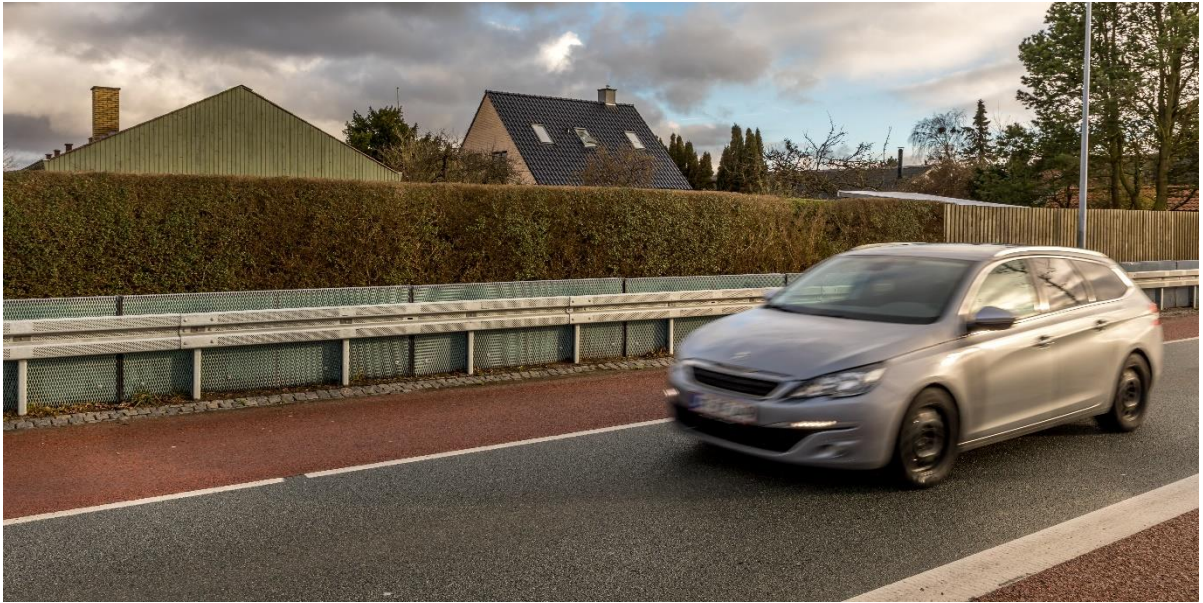
Figur 28. Autoværn, der er udformet som en lav støjskærm. Selvom skærmen er lav, kan der være en støjdæmpende virkning, fordi den står meget tæt på støjilden (Vejlegårdsvej, Vallensbæk Kommune).
