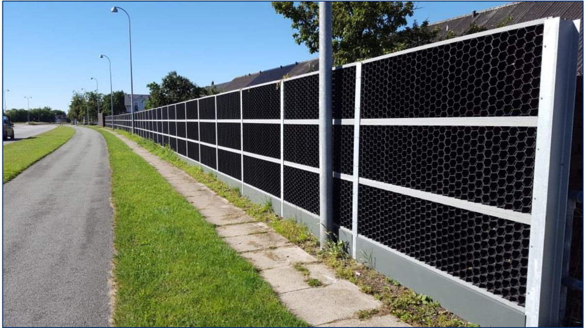
Figur 26. Eksempel på støjskærm langs et boligområde. De sorte akustiske elementer i skærmen består af materiale fra genbrugte vindmøllevinger (Vallensbæk).
